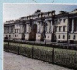
Здание Сната в Санкт-Петербурге
