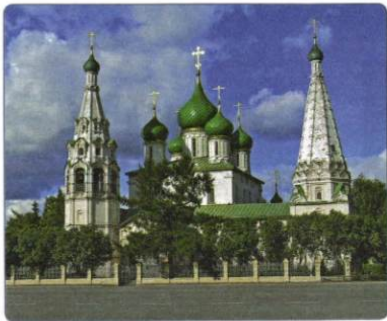
Церковь Ильи Пророка в Ярославле
